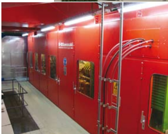
Bei Munksjö Paper in Aalen wird eine Gasturbine mit einem Braunkohlenstaubkessel kombiniert
