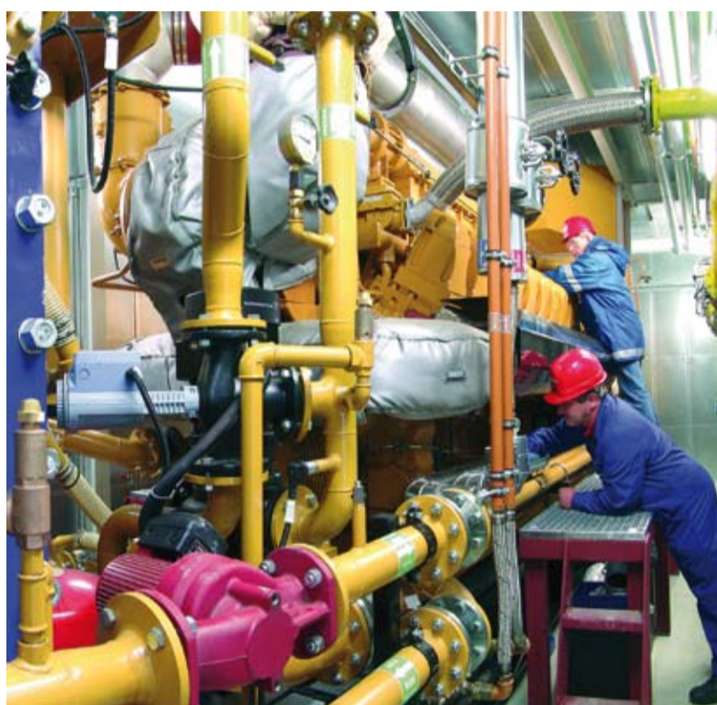
Drei Standorte – ein einheitliches BHKW-Konzept
