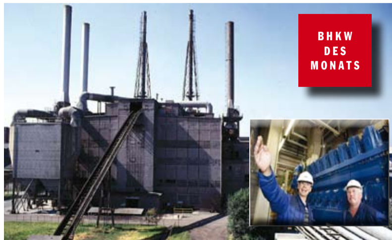
Die Installation dreier Gasmotorenaggregate und eines Abhitzeessels ist die letzte Stufe der Modernisierung eines 40 Jahre alten Heizkraftwerks in Ludwigshafen
