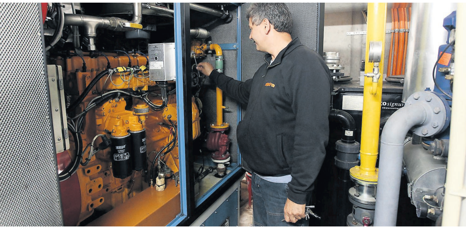
Durch das Prinzip der Kraft-Wärme-Kopplung generieren Blockheizkraftwerke Strom und Wärme aus einem einzigen Motor. FOTO: DPA
