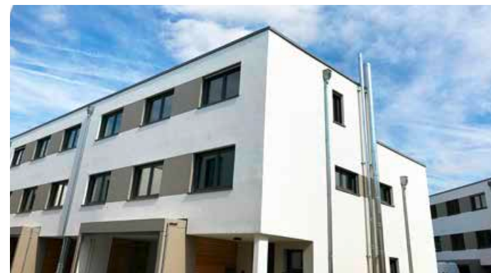
In Mainz-Hechtsheim ist ein neues Quartier entstanden mit einer sektorübergreifenden Energieversorgung
