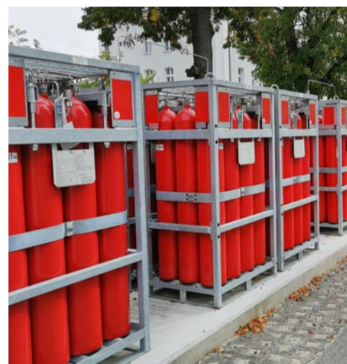
Wasserstoff-Flaschenbündellager am Campus der OTH Amberg-Weiden
