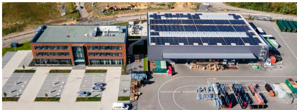
Die neue Firmenzentrale der PlanET Biogas Group GmbH in Gescher
