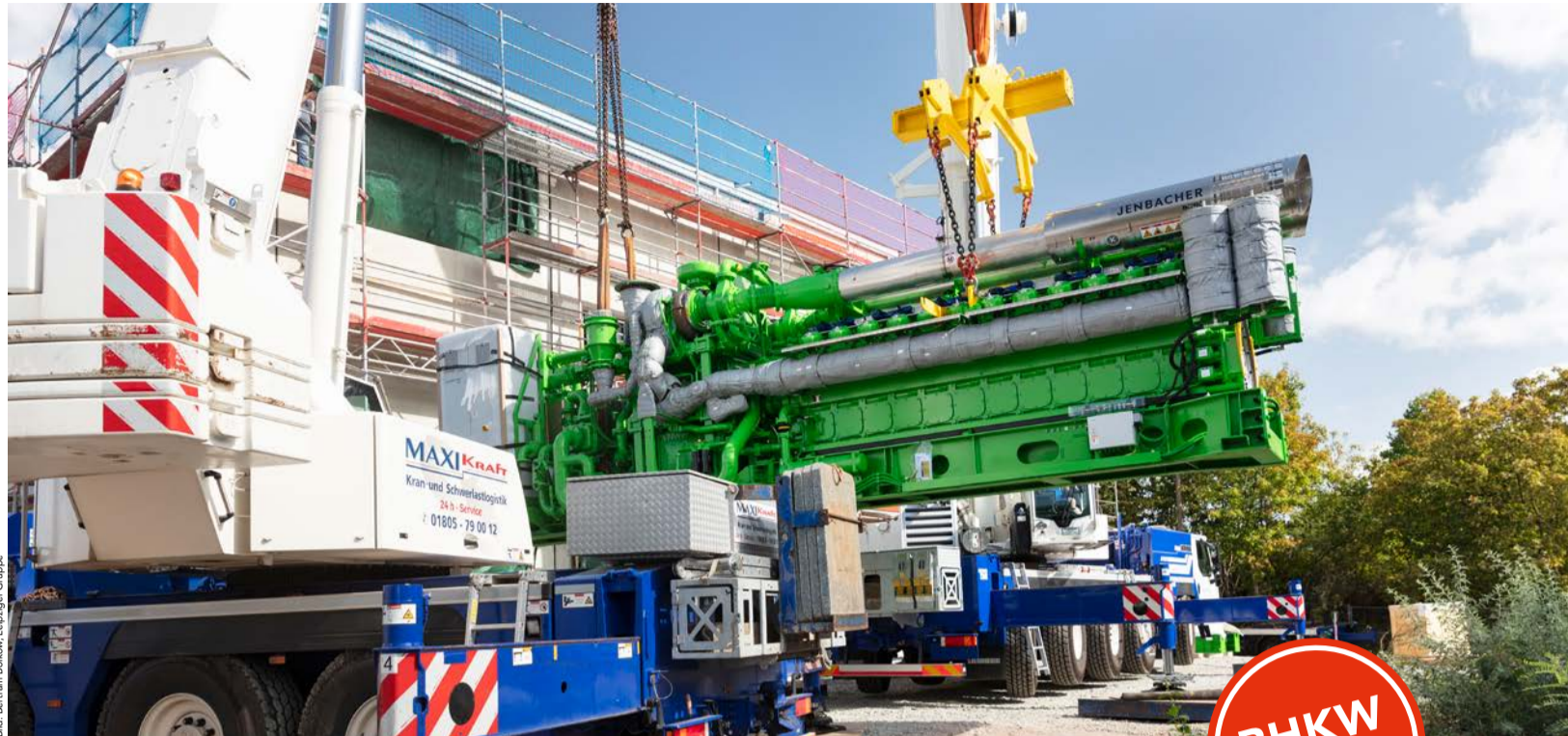
Ein Kran hebt das neue Blockheizkraftwerk in das Gebäude an der Diderotstraße
