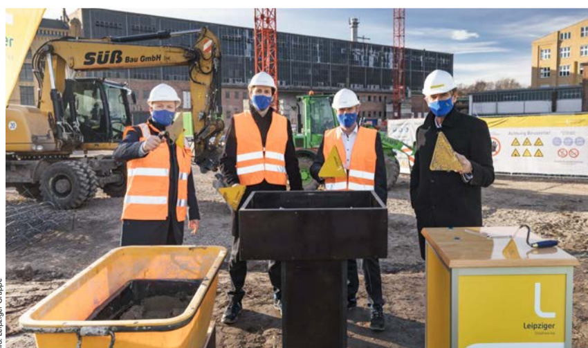
Grundsteinlegung für das neue Heizkraftwerk Leipzig Süd (v.l.): Thomas Brandenburg, Maik Piehler, Karsten Rogall und Burkhard Jung
