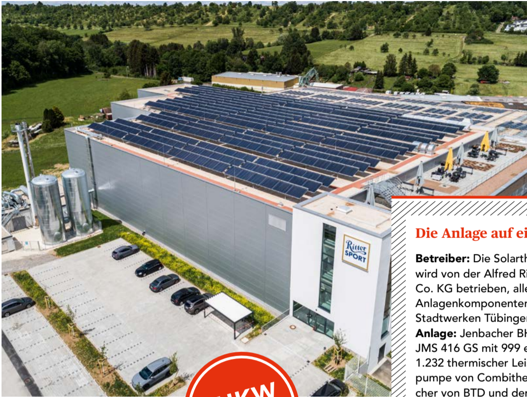
Eine Solarthermieanlage und eine KWK-Anlage versorgen Dettenhausen mit Fernwärme. In der Energiezentrale Dettenhausen ist ein Jenbacher BHKW installiert (l.).
