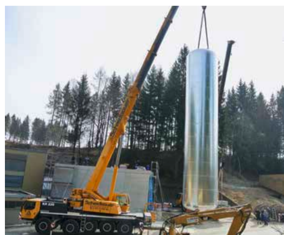
Beim Bau der energetischen Infrastruktur im Jahr 2020: Der Pufferspeicher wird installiert
