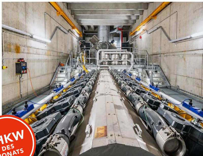
Die neuen Motoren in Pforzheim ersetzen den alten Kohleleiler vollständig
