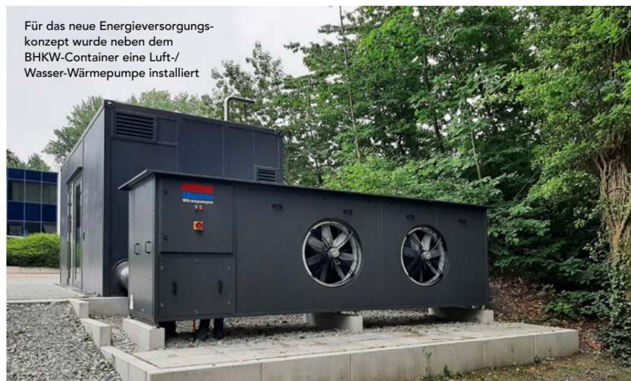
Für das neue Energieversorgungskonzept wurde neben dem BHKW-Container eine Luft-/Wasser-Wärmepumpe installiert
