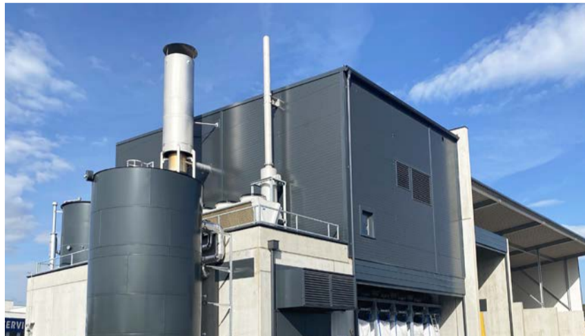
Das Holzkraftwerk im österreichischen Ternitz
