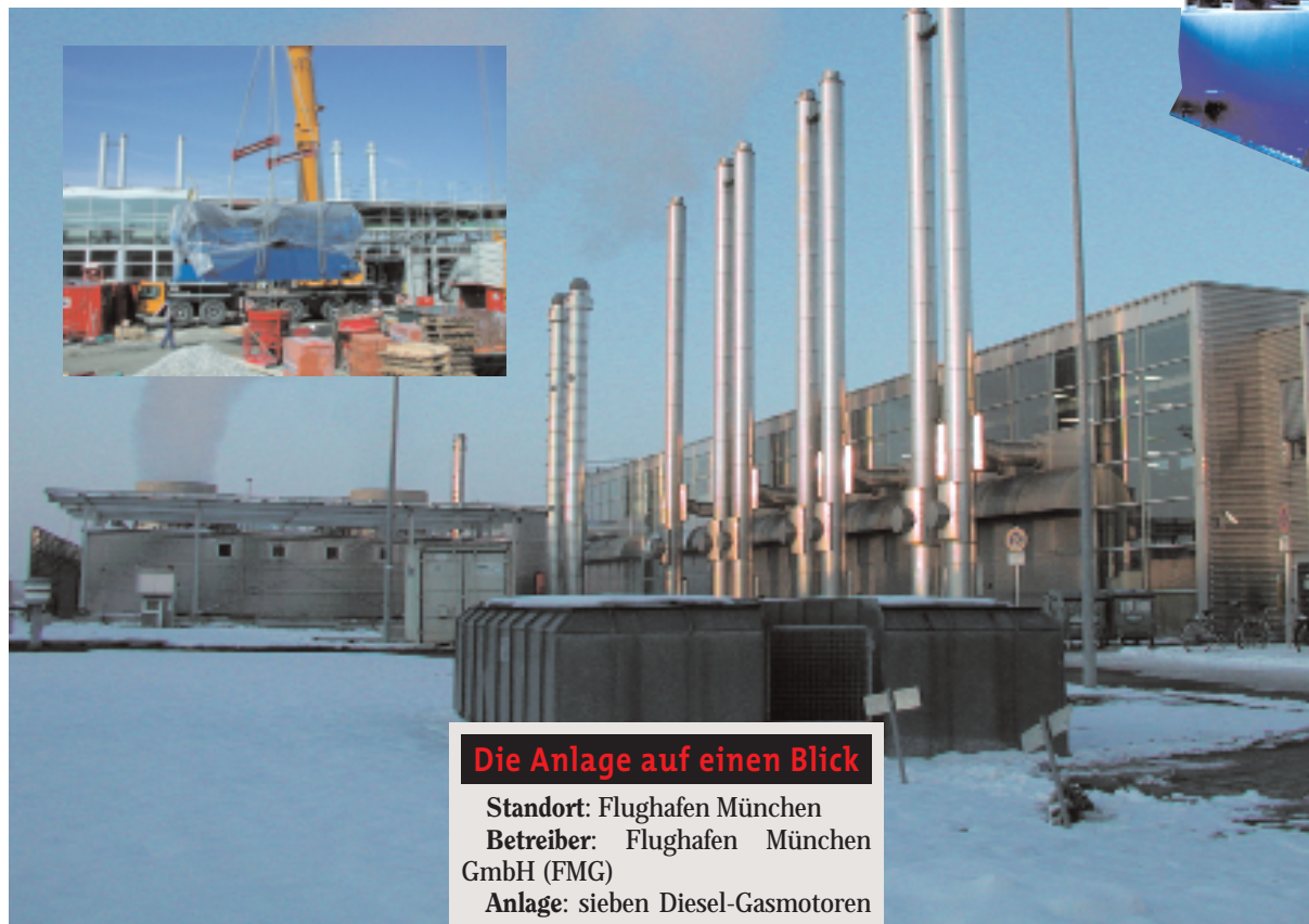
BHKW am Flughafen München: Erweiterung um zwei Ottogasmotoren und vier Absorptionskältemaschinen
