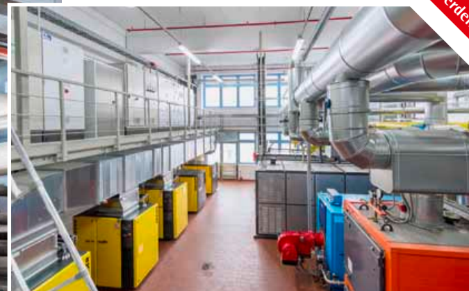
In der Energiezentrale sind die BHKW (hinten rechts) und Reservekessel (vorne rechts) sowie die Druckluftanlagen mit der Wärmerückgewinnung zusammengefasst
