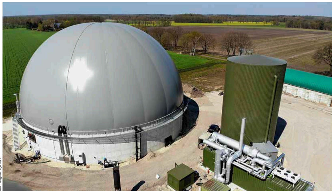
Der neue Gasspeicher, der Wärmespeicher und das BHKW im regenerativen Speicherkraftwerk
