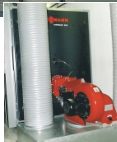
BHKW für Sparkassen-Zentralverwaltung in Bad Kreuznach: 50 kW-Modul von Comuna Metall, 575 kW-Spitzenlastkessel von Viessmann
