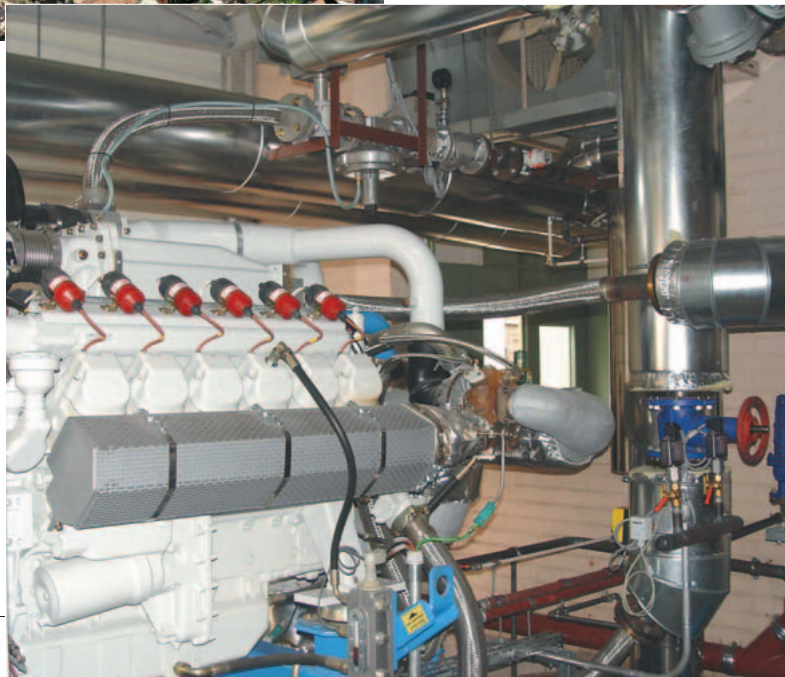
20 m 3 -Wärmespeicher und Notkühler sorgen für einen flexiblen Betrieb des dritten BHKW-Moduls bei Allweiler
