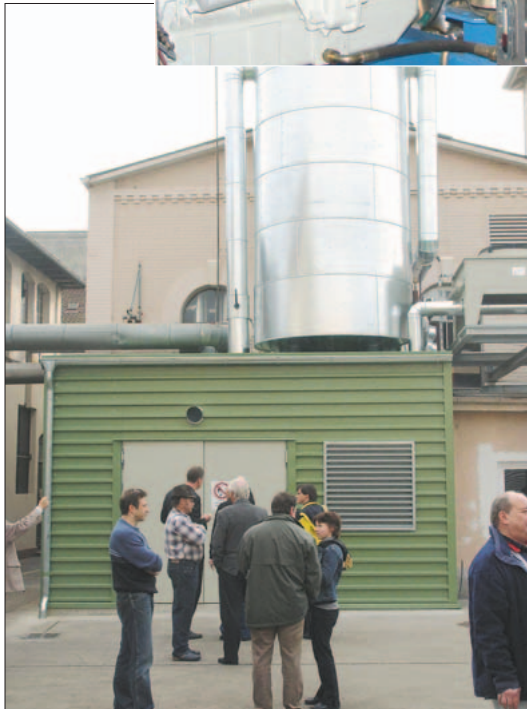
20 m 3 -Wärmespeicher und Notkühler sorgen für einen flexiblen Betrieb des dritten BHKW-Moduls bei Allweiler
