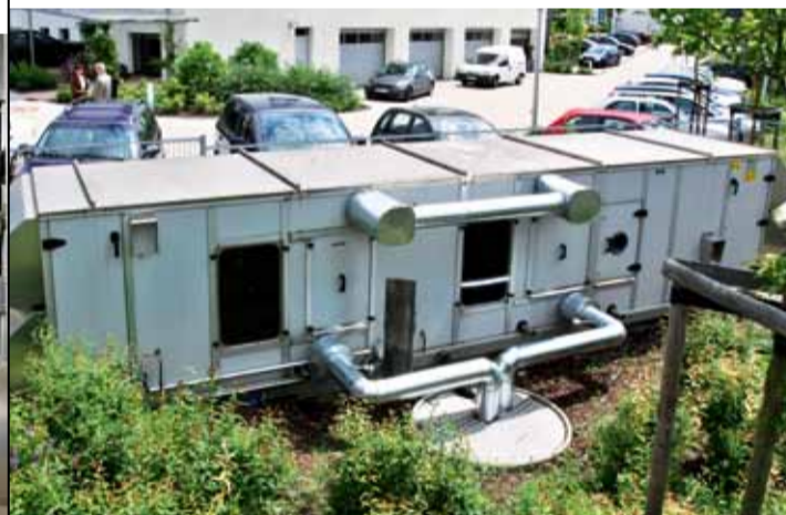
Doppelfunktion: Freikühler und Rückkühler für die Absorptionskälteanlage
