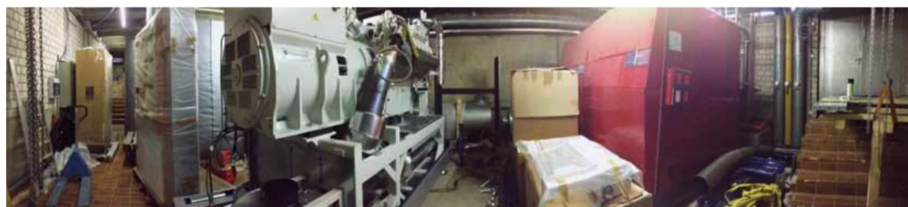
Bauabschnitt 5 in der Thiebauthschule
