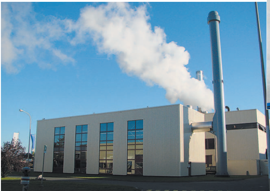
KWK deckt den gesamten Energiebedarf des Michelin-Werkes in Hallstadt: 6,3-MW-Gasturbine und zusatzgefeuerter Abhitzekegel mit 30 t/h Dampfleistung
