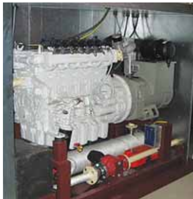
Das BHKW der Sommer energy deckt 70 % des Wärme- und 85 % des Strombedarfes der Casa Familia
