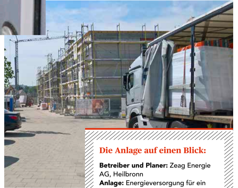
Baustelle Gemrigheim: Seit 2016 entstehen dort neue Wohngebäude
