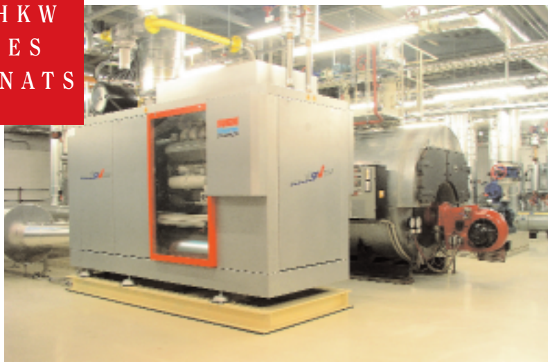
Für Kraft-Wärme-Kälte-Kopplung ausgelegt: zwei 340 kW-Kompakt-Module von Sokratherm bei Procter & Gamble in Crailsheim
