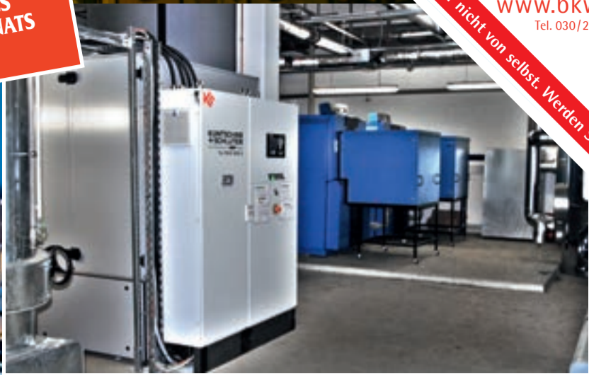
BHKW im Maritim Hotel am Flughafen Düsseldorf: mit Brennwertwärmetauscher Gesamtnutzungsgrad von fast 100 Prozent
