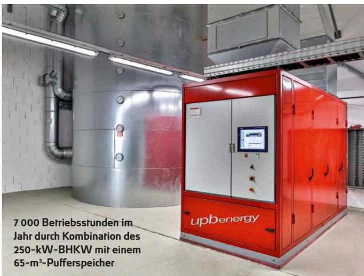
7 000 Betriebsstunden im Jahr durch Kombination des 250-kW-BHKW mit einem 65-m<sup>3</sup>-Pufferspeicher
