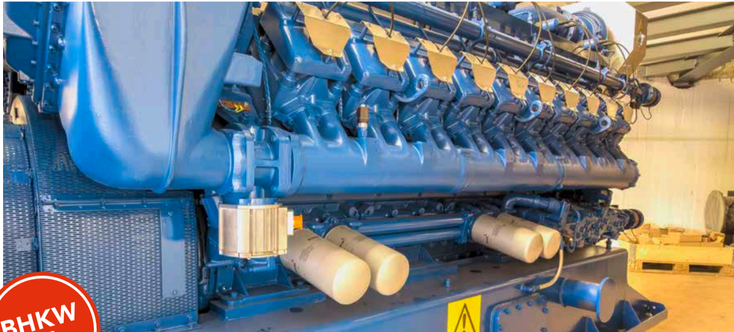
Ein BHKW mit knapp 2 MW elektrisch und 2,2 MW thermisch steigert die Eigenproduktion in Lübeck
