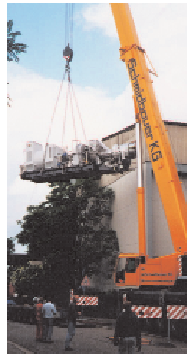
Die neue Gasturbine schwebt ein
