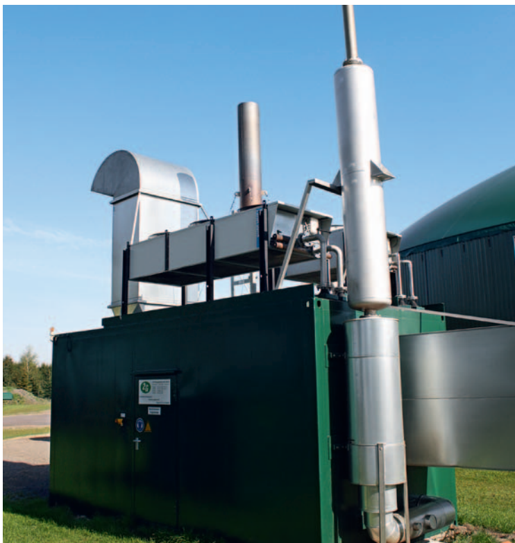
Vor Ort auf effiziente Motorentechnik umgerüstet: Container-BHKW der 2G
