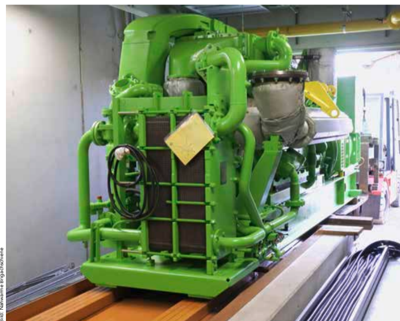
Der vierte Motor für die Nahwärme Brigachschiene wird angeliefert
