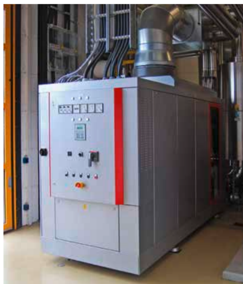
Das erste BHKW bei Sartorius hat seit der Inbetriebnahme im Februar 2008 über 87 000 Betriebsstunden absolviert
