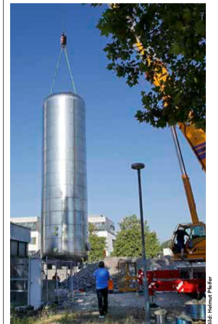
Die Anlieferung des neuen 100-Kubikmeter-Speichers des Herstellers Dehoust in Walldorf Anfang August
