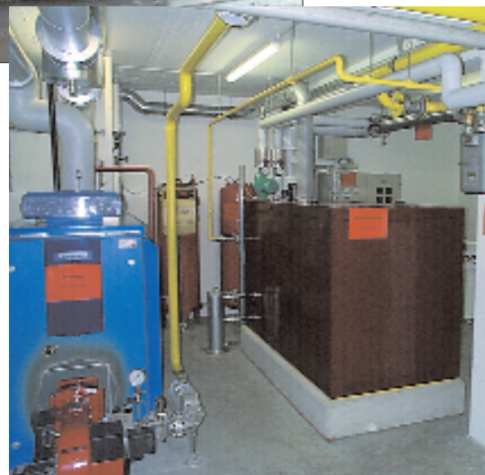
410-kW-Heizkessel von Buderus und 50-kW-BHKW-Modul von Comuna Metall in einer denkmalgeschützten Scheune
