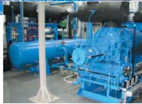
1 MW Wärme und 220 kW Strom stellen im AquaMagis die York-Wärmepumpe und das MWB-Blockheizkraftwerk im Kombi-Betrieb aus Walzöl-Abwärme und Erdgas bereit (Foto: Marcel Hoefsloot)
