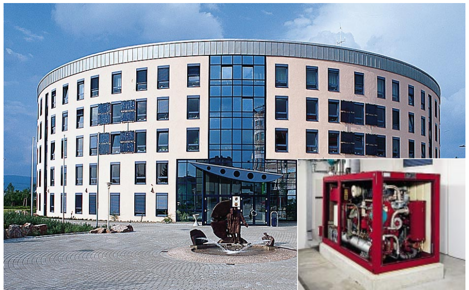
Abb. 1: BHKW-Nahwärmeversorgung für das Kreishaus Ingelheim (Fotos: COMUNA metall)
