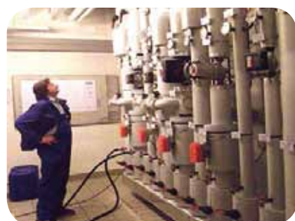
Ein Alpenland-Mitarbeiter bei der Neubefüllung mit demineralisiertem Energywasser 2035
