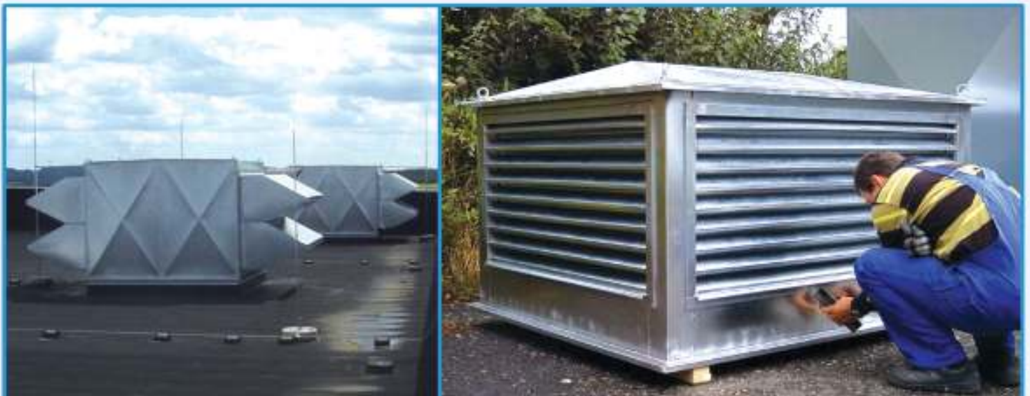
Dachhauben und Hutzen in verschiedenen Bauformen zur Zu- und Abluftführung
