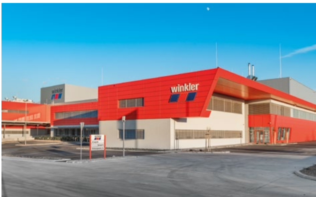
Logistikzentrum in Himberg, Österreich.
