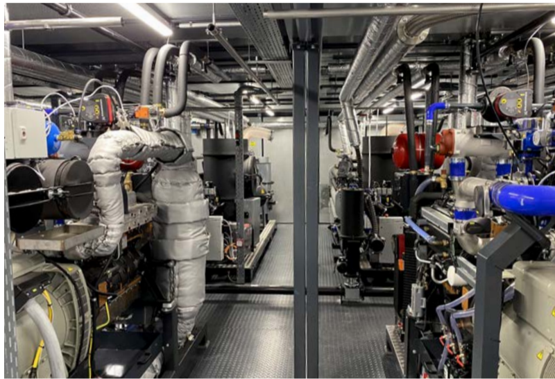
Die Anlage wurde als Containerlösung angeliefert
