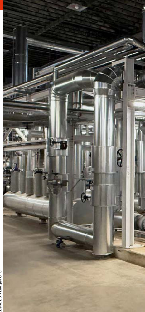
Quelle: Iqony Energy GmbH
