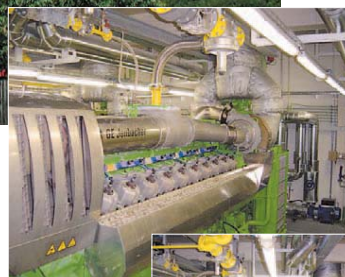
Wo früher im Heizkraftwerk der Stadwerke Rosenheim Müllkessel standen, liefern nun drei 3 MW-Gasmotoren-Module der GE Jenbacher effektiv Strom und Wärme
