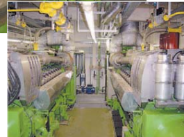
Wo früher im Heizkraftwerk der Stadwerke Rosenheim Müllkessel standen, liefern nun drei 3 MW-Gasmotoren-Module der GE Jenbacher effektiv Strom und Wärme
