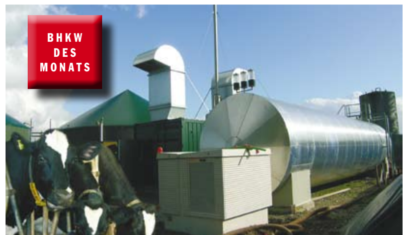
Eine Biogasanlage, zwei Blockheizkraftwerke und eine Biogasleitung für die Wärmeversorgung der Siedlung Polderwijk in der Gemeinde Zeewolde
