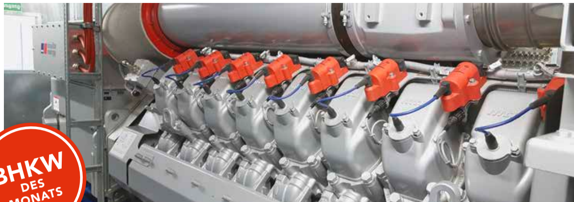
BHKW bei Ritter Sport: Abgaswärme für Kälteerzeugung genutzt
