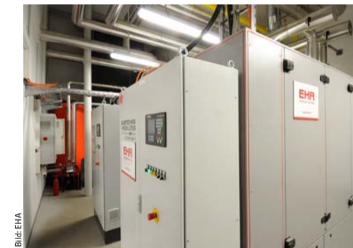
Über einen Pufferspeicher eingebunden: zwei BHKW-Module von Kuntschar + Schlüter
