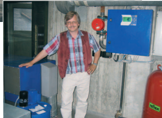
Ökologie und Ökonomie im Naturpark vereinigt: Modulierendes Dieselmotor-BHKW der dänischen EC Power im Erholungs- und Bildungszentrum Wittensee
