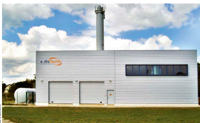
Kein freier Platz für BHKW-Erweiterung: Heizkraftwerk Werder (Havel)
